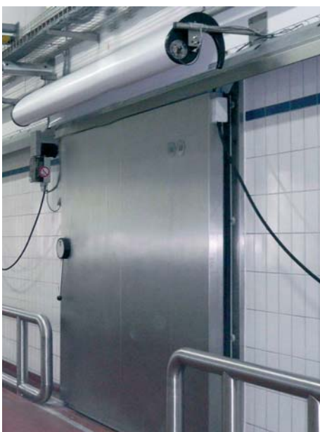
Abbildung 01 Die Luftschleieranlage wird oberhalb der Gefrierraumtür montiert und sorgt somit für ein problemloses Betreten des Kühl- oder Gefrierraums.
